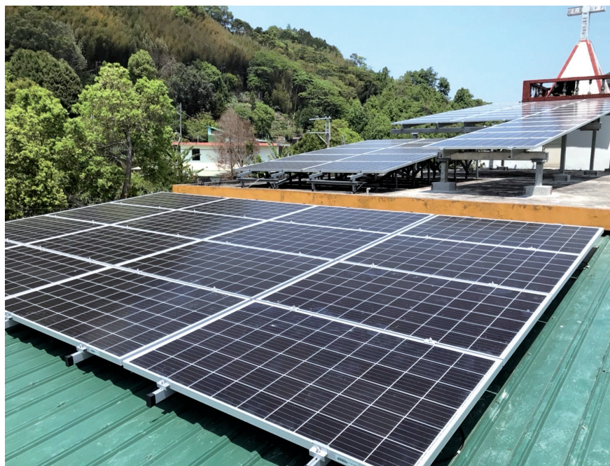
設置於比亞外教堂屋頂的19KW的太陽能板。
