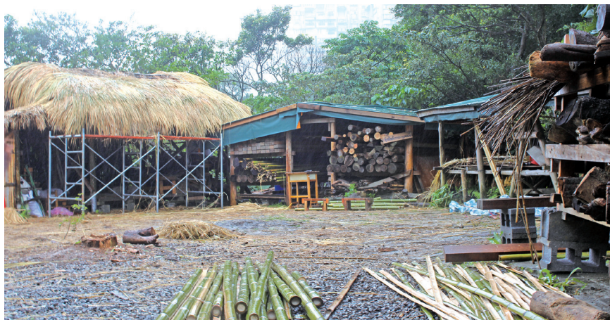
傳統竹屋搭建現場。
