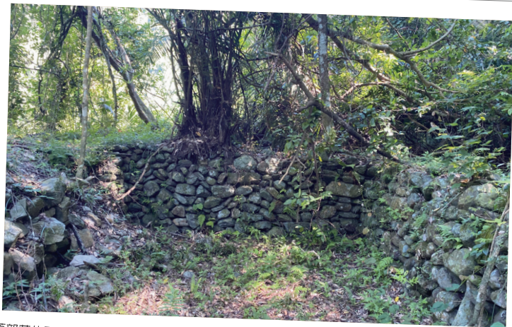
舊部落的駁坎遺跡。
